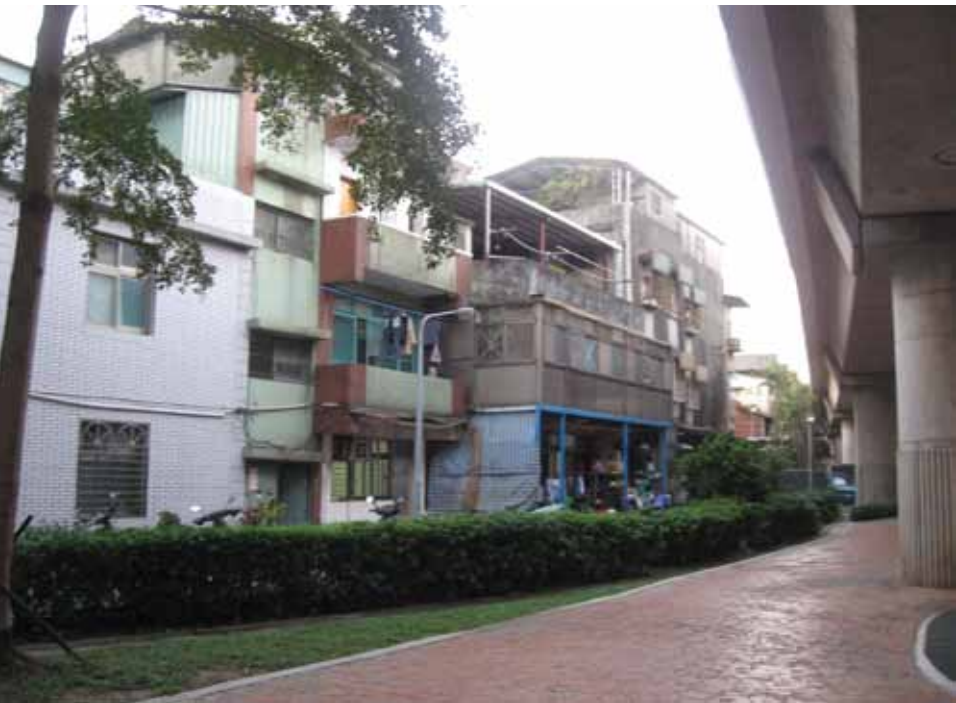
拆除前現況 與捷運淡水線高架僅有2.3m距離
